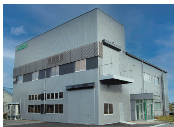
加工センター 第二工場
