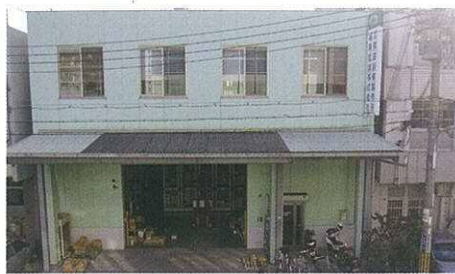
株式会社隅田鉄螺製作所第二事業所・城東製鉄株式会社
