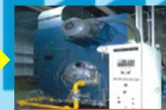
既設ボイラー
