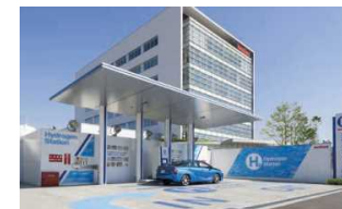
中規模 水素ステーション
